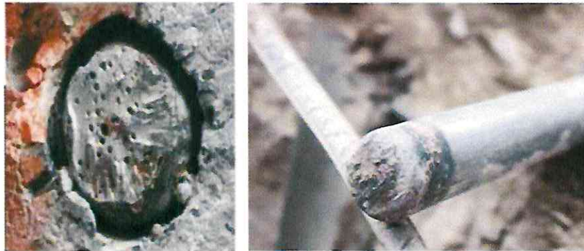
Figura IV.1.8 – Detalle de los pernos Nelson
