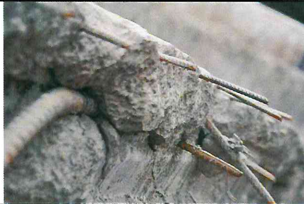
Figura IV.1.16 Detalles de Varillas
