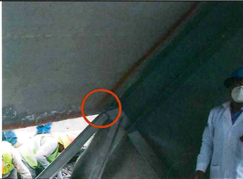
Vista general del contraventeo (CV1) – trabe T-7
