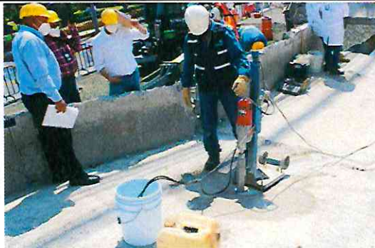
Instalación del equipo extractor de núcleos
