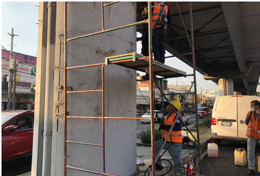
Columna 205. Inyección de resina epoxi.
