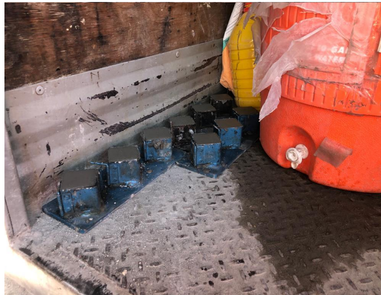
Columna 277 y 276. Muestra de Grout del colado de bajantes pluviales.
