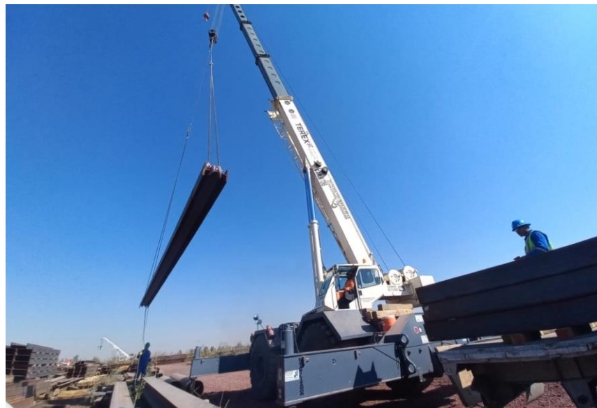
Embarque de perfiles estructurales
