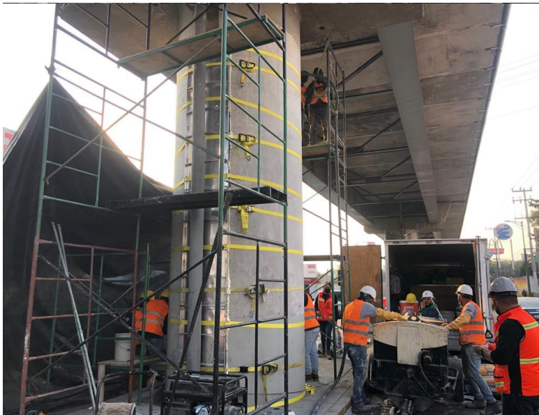
Columna 276. Colado de bajantes pluviales.
