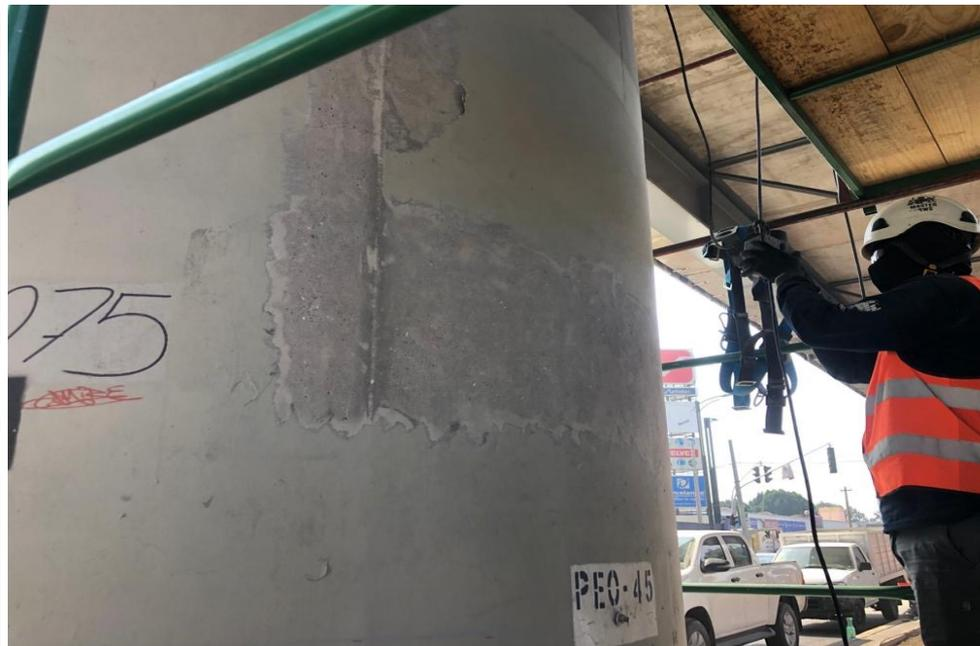
Columna 280 - Limpieza mecánica para preparación de superficie
