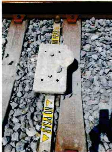
Figura 12. Fotografía que muestra una baliza del subsistema CBTC a los lados de la vía, un transpondedor electrónico utilizado dentro de un sistema automático de protección del tren (ATP por sus siglas en inglés).
