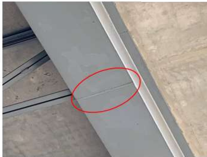
Empalmes de vigas metálicas longitudinales en el centro de la trabe
