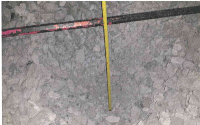
Foto 8. El balasto contiene una cantidad de finos importante - PK 24+200
