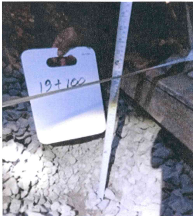
Foto 21. Balasto con poco humedad (PK19+100)
