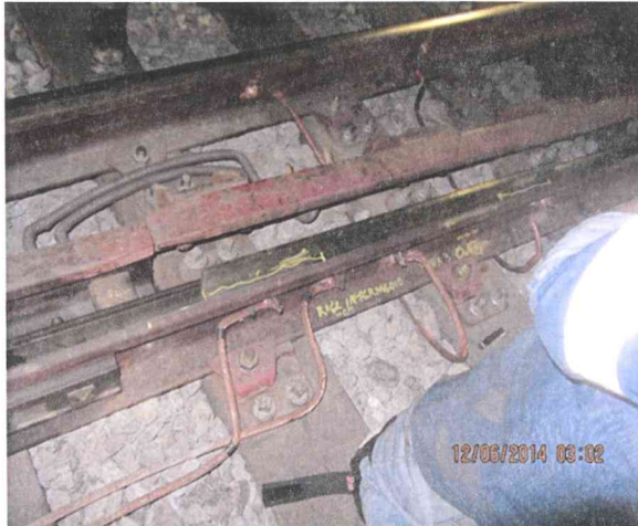
Foto 12. Desgaste geométrico-Comunicación 13/23
