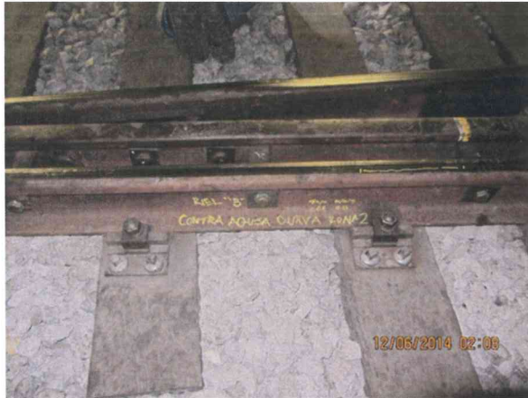
Foto 11. Desgaste geométrico-Comunicación 13/23
