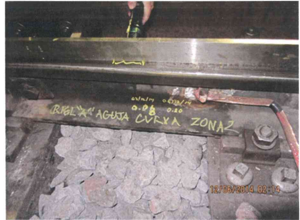
Foto 11. Desgaste geométrico-Comunicación 13/23
