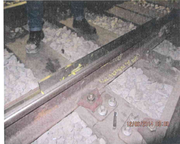
Foto 12. Desgaste geométrico-Comunicación 13/23
