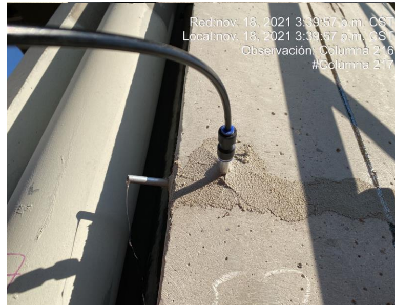
Puerto siendo inyectado con resina epoxi.
