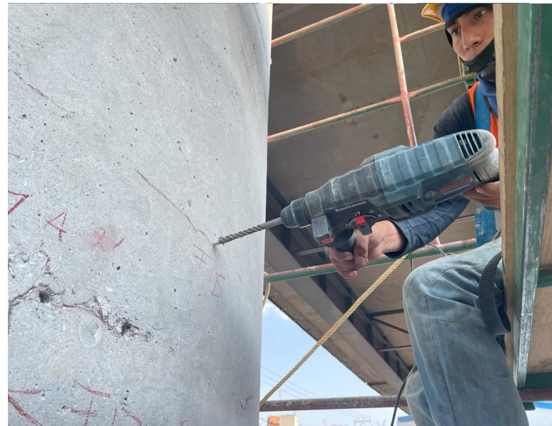
Barrenado donde se colocaran los puertos de inyección en las columnas 217, 219 y 220.
