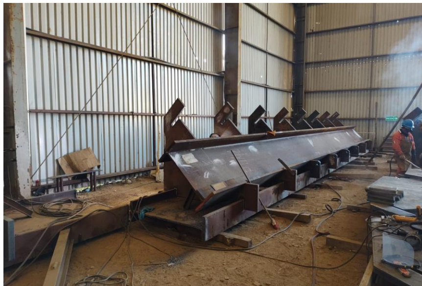
Colocación de perfiles en las áreas de trabajo.
