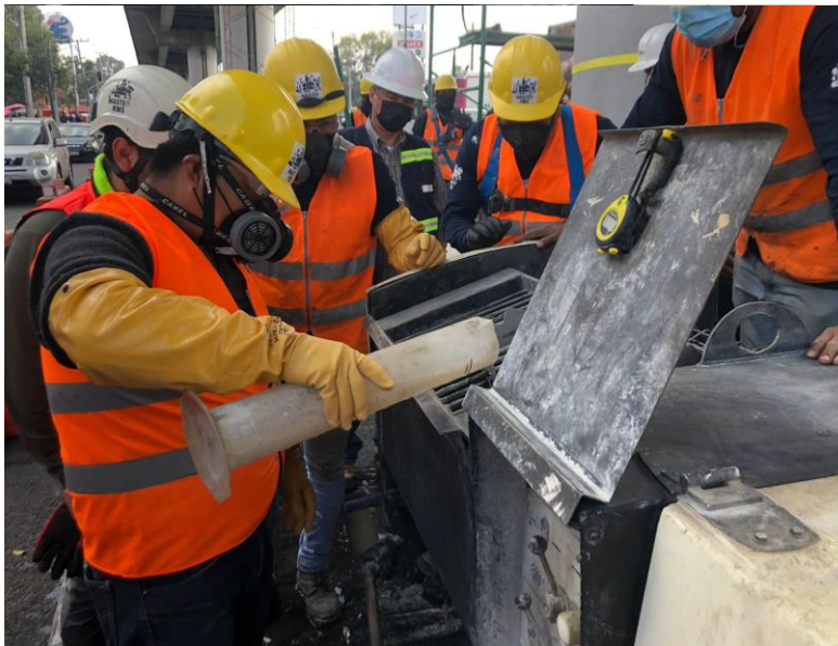
Columna 285. Dosificación de materiales para mezcla de Grout.
