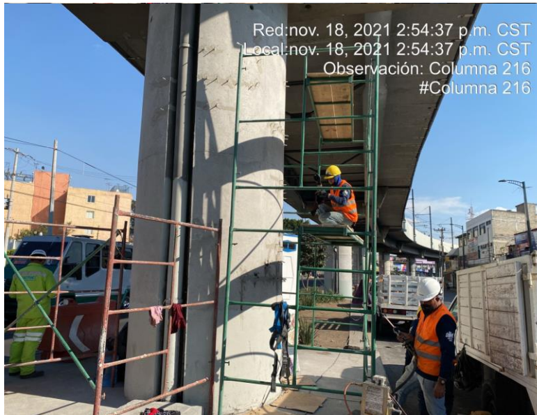
Inyección de resina epoxi.
