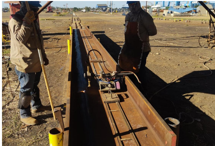
Ajustes en los equipos de corte.
