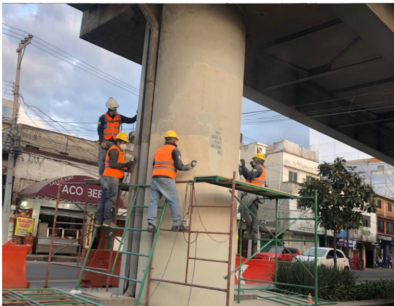
Columna 208. Preparación de superficie para identificación de grietas.
