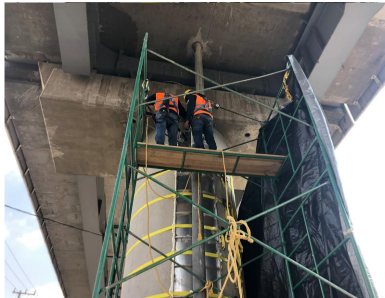
Columna 285. Colado de área de bajante pluvial, lado oeste.
