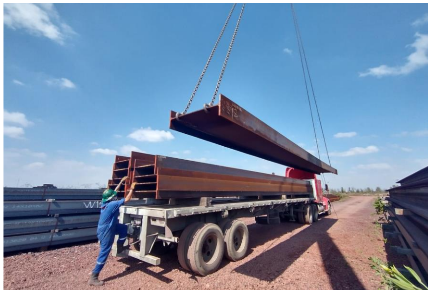
Embarque de vigas, acero A992 GR50.
