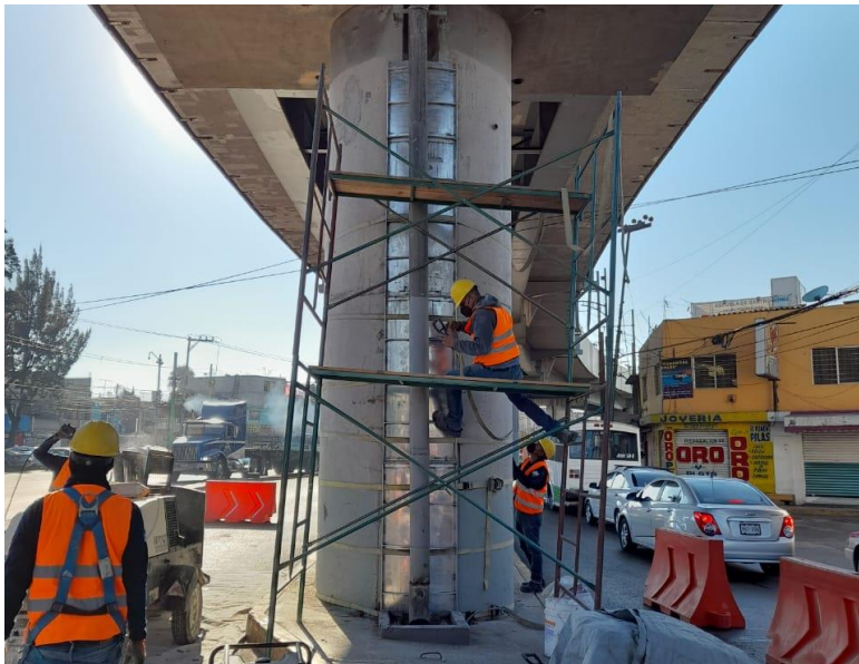
Colado de bajantes pluviales.
