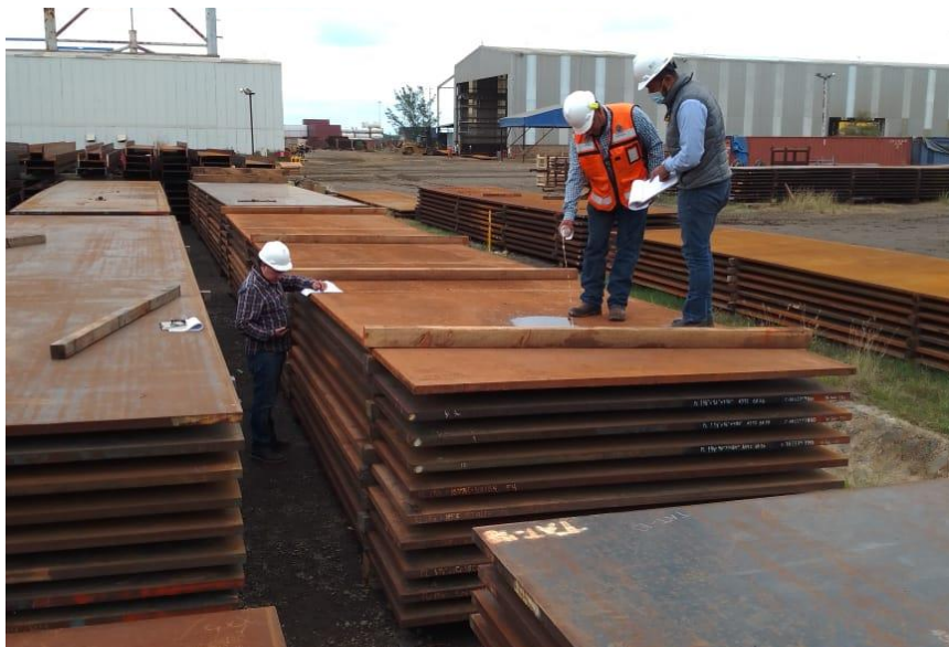
Verificación del metal base.
