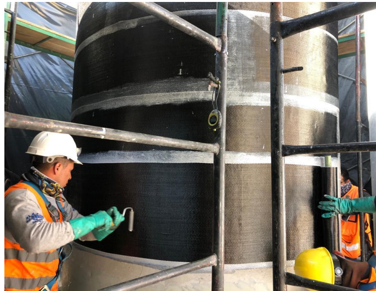
Pasadas con rodillo liso para expulsar el aire y adherir la fibra a la impregnación.
