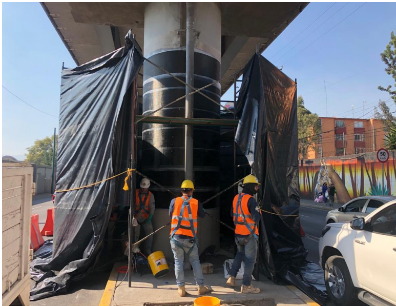
Preparación para colocar la segunda capa de fibra.
